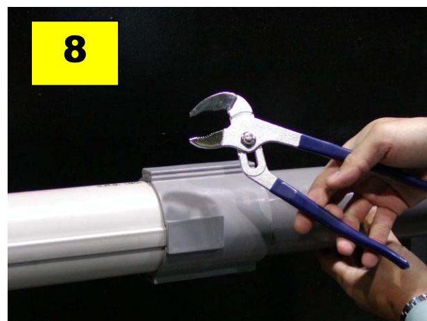
接合には、アジャスタブルプライヤー (ウォーターポンププライヤー)が便利です
