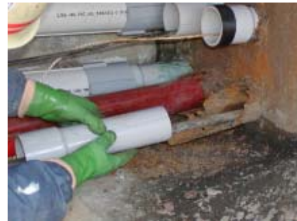
レジューサー設置 2
