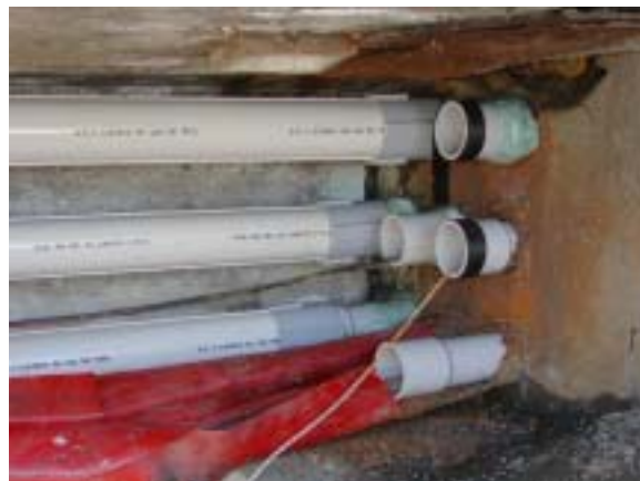
レジューサー設置 4
