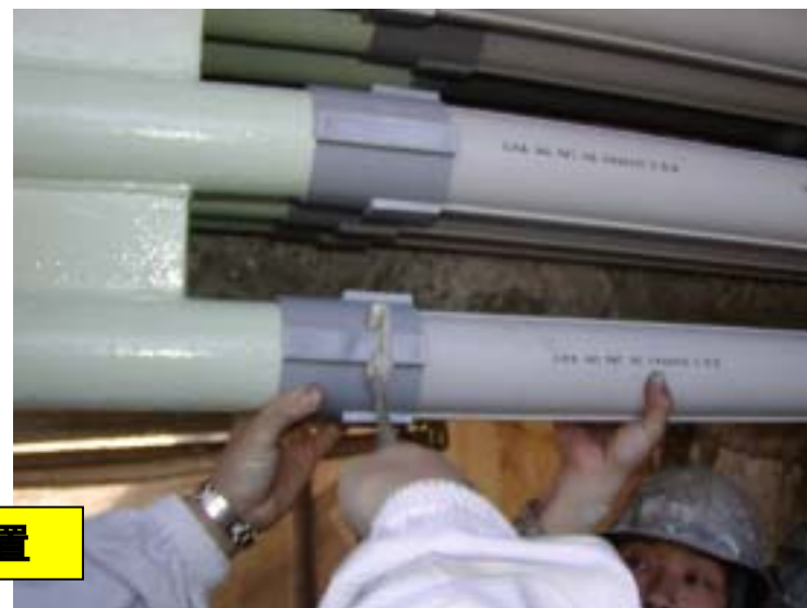
スプリットダクト設置
