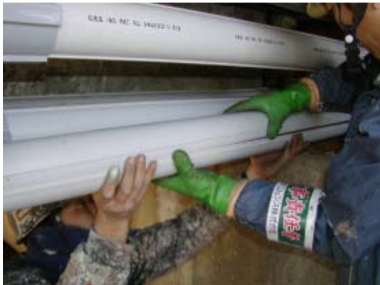
スプリットダクト設置
