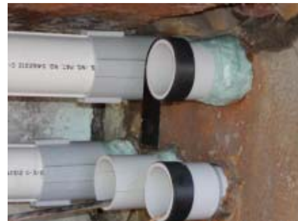
レジューサー設置完了
