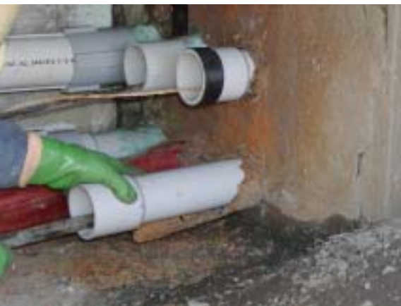
レジューサー設置 3
