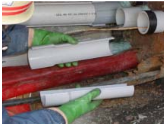
ジーサー設置 1
